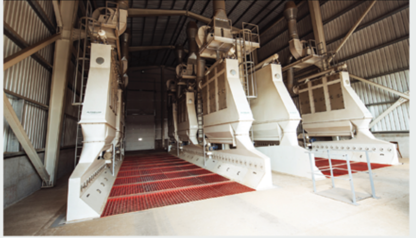
Tozsuzlaştırılmış Mal Alım Çukuru
